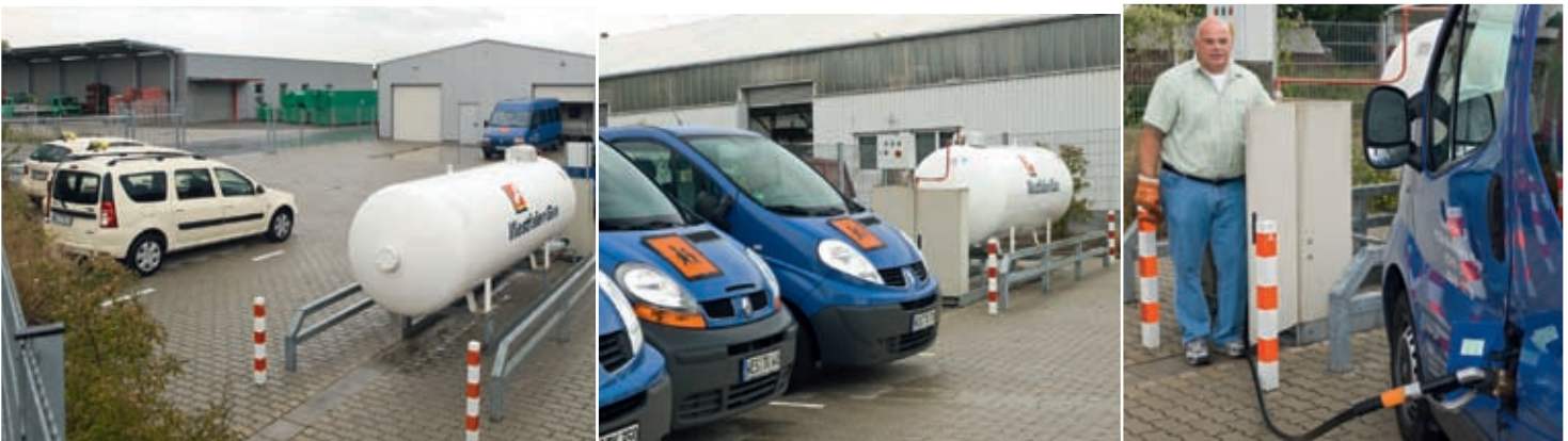
14 der insgesamt 23 Taxen und Minibusse sind derzeit mit LPG unterwegs. Die eigene Autogas-Tankstelle mit 4.000-Liter-Tank braucht kaum mehr Platz als ein normaler Parkplatz. Kanther: „Autogas lohnt sich und mit der eigenen Tankstelle spare ich nochmals rund fünf Cent pro Liter.“
