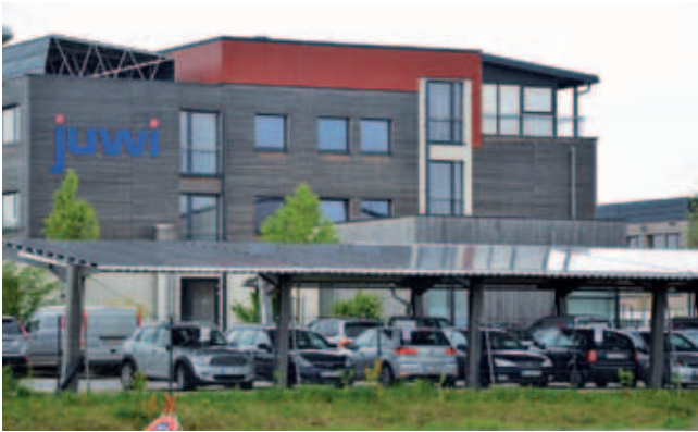
Holzbau | Die Firmengebäude werden durch regenerative Energie versorgt
