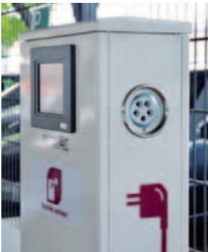
Energienachschub | Über eine Magnetkarte aktivierbare Ladestation
